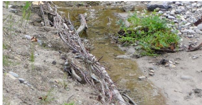
Abb: Bachrevitalisierung mit Begleitstrukturen, z.B Holz für Ufersicherung
